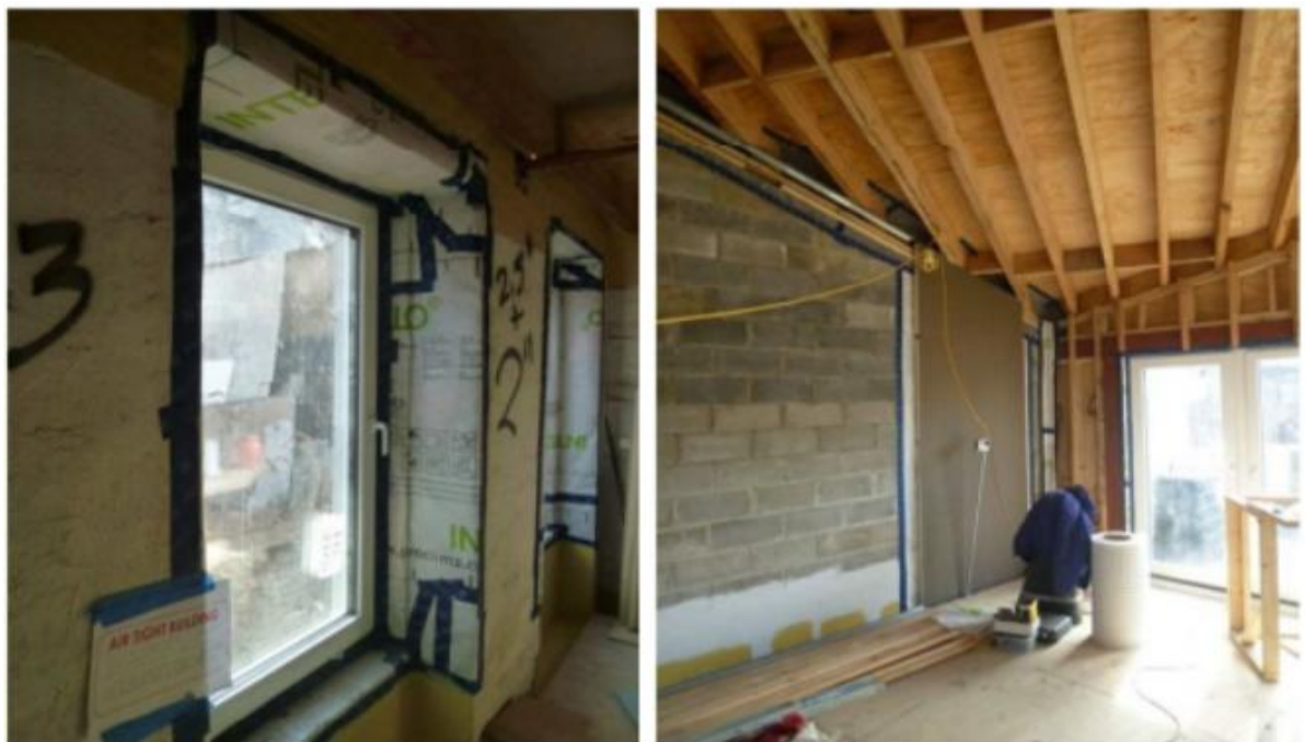
접합부 기밀테이프 시공
