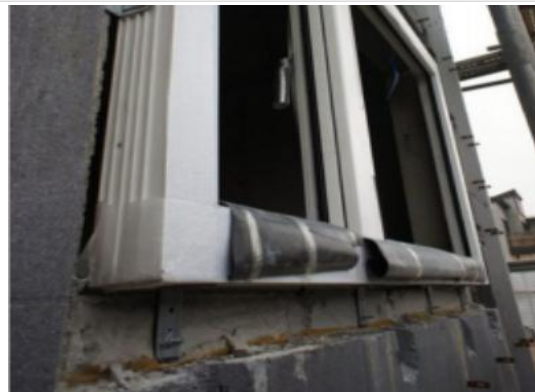
외단열 건물의 창호 고정물 설치
