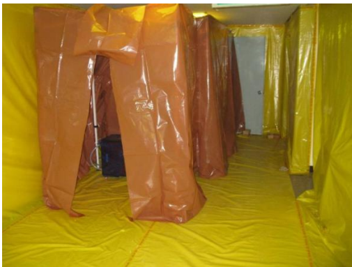
석면제거 및 내부철거 분리보호막 설치
