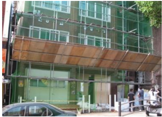
외벽 리모델링 작업시 재해방지
