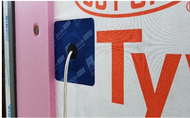
기밀테이프를 이용한 전기배선 기밀 확보
