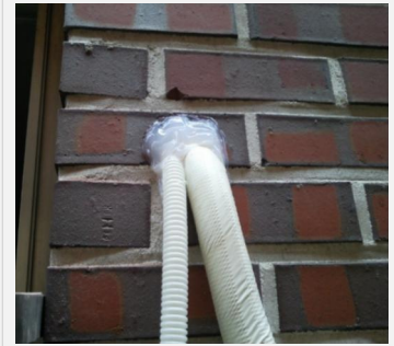
냉매배관 틈새 시공 후
