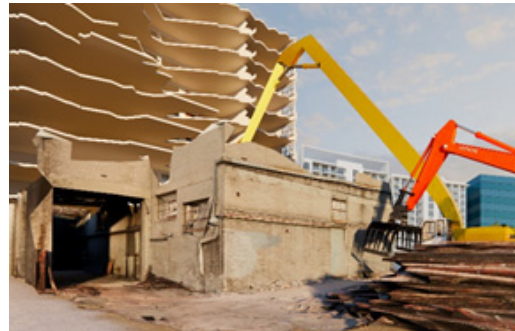
하부층 서포트 설치 후 장비 투입
