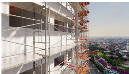
작업자 및 외부 비산먼지 방지 등을 위한 비계 설치 및 통행로 확보
